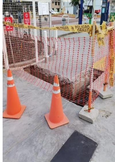
*Corte, picado y excavación de zanja*
