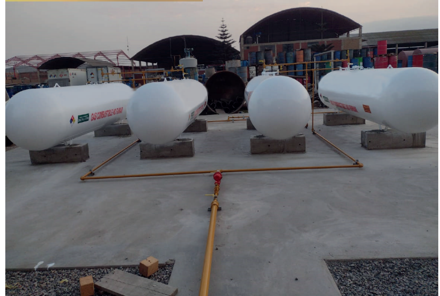
PROYECTO CHEMICAL MINING Mantenimiento de tanques
