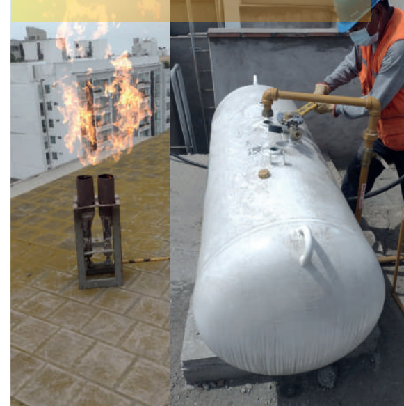
PROYECTO EDIFICIO ANGAMOS Cambio de valvulerías
